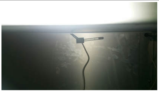
Installierte Fühler (Mitte), Nähe zu Überwachungsfühler
